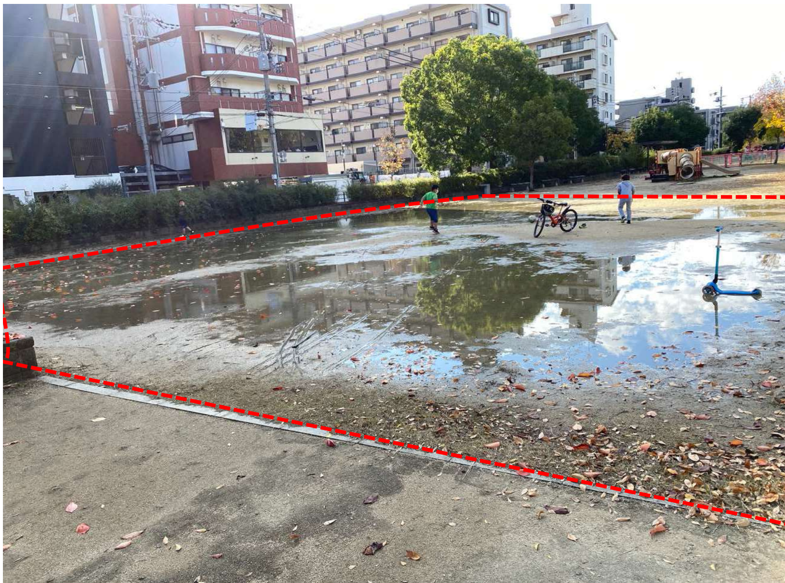
現況写真 期間：2023.3.15（水）～2023.3.18（土） 工事名：緑地橋口遊具広場不陸修正
